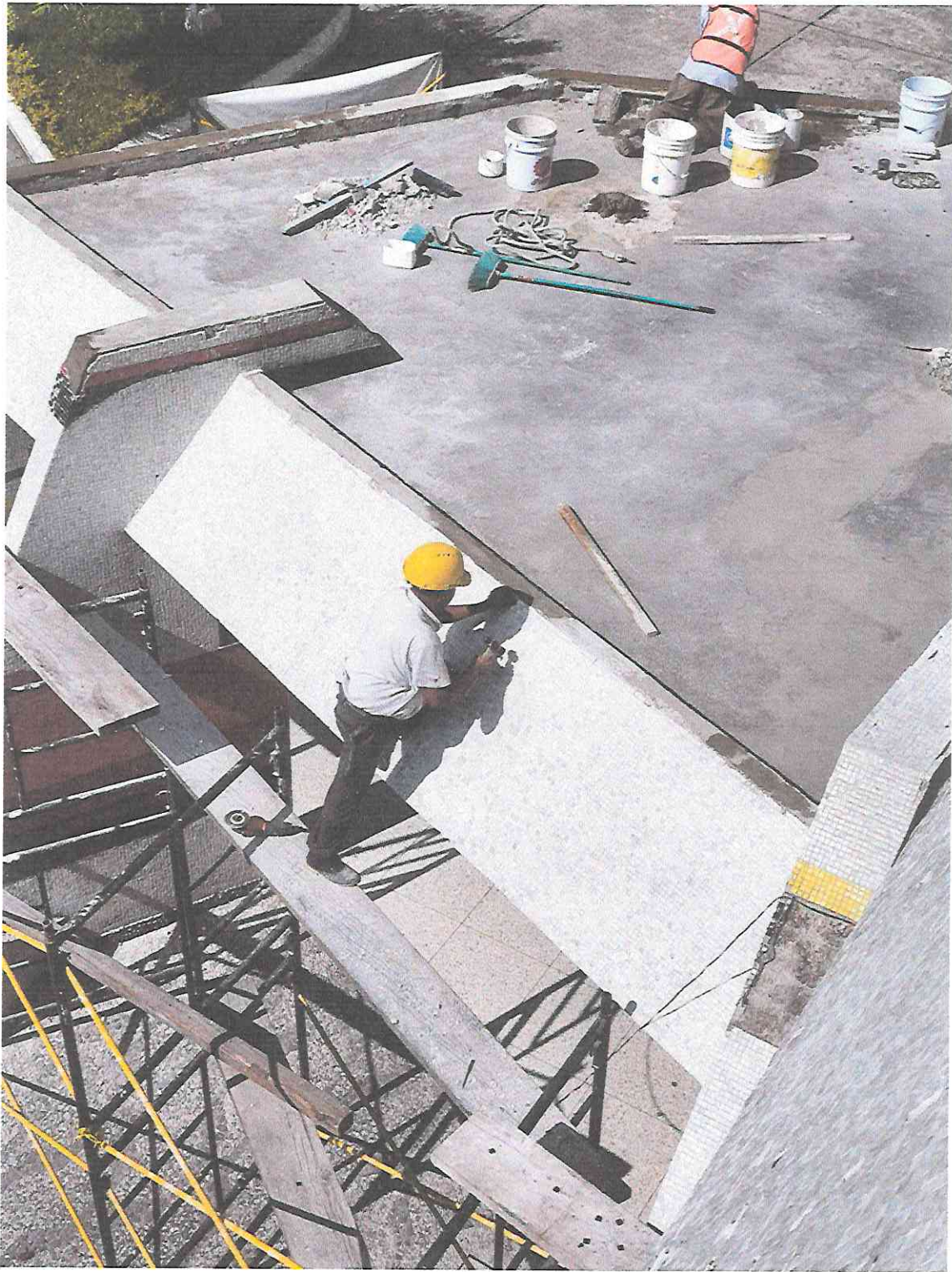
TRABAJOS DE LIBERACIÓN DE AGREGADOS EN PARTE SUPERIOR DEL INGRESO DEL TEATRO DE CÁMARA - SEGMENTO TC
